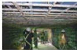
측벽 및 상부 철근조립
