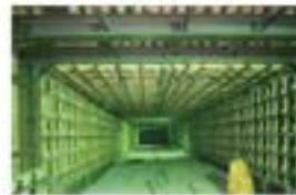
벽체 및 상부 타설 구체방수
