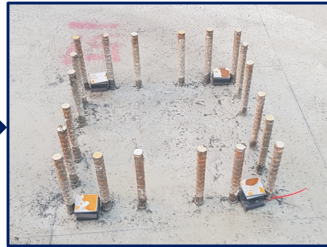
기초 바닥 콘크리트 타설
