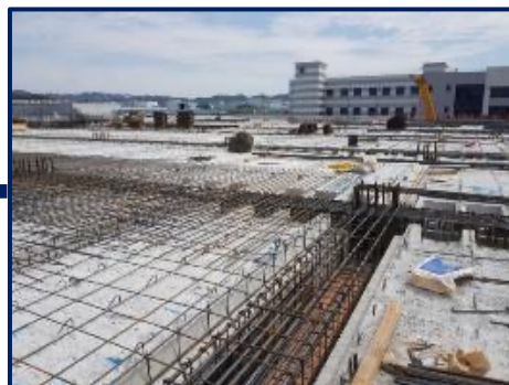
현장 철근 배근
