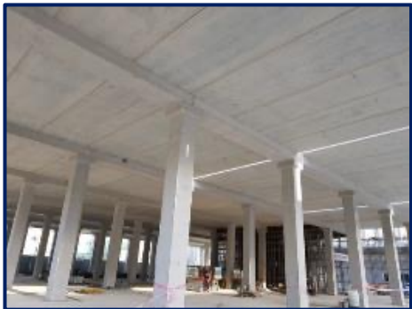
조립 후 전경(상부)
