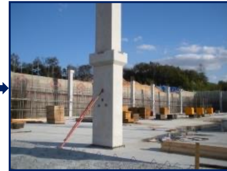
기둥 서포트 설치
